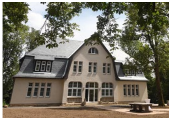
Durch die aufwendige Sanierung ist das historische Klinikgebäude ein Schmuckstück geworden. FOTO: BASTIAN FRANK
